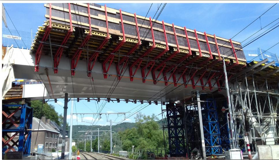
*Dans la nuit du 27 au 28 juin 2020, deux caissons métalliques (blancs) sont placés au-dessus du chemin de fer et son prolongement. Le montage en bois accroché au pont sert de sécurité aux ouvriers travaillant sur le pont.*
