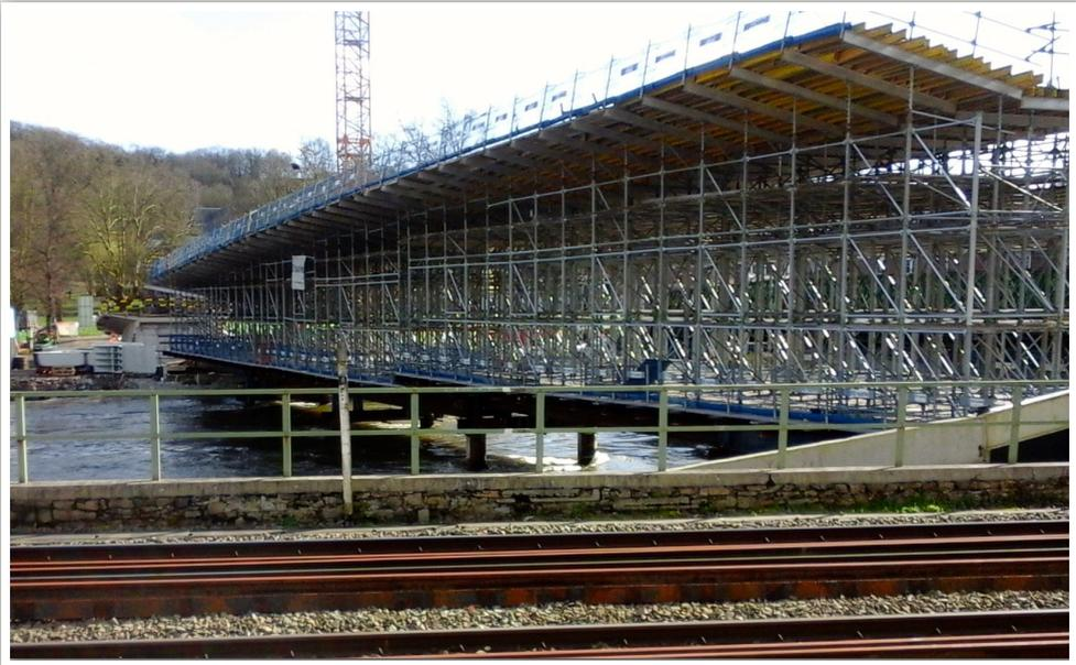
*En mars 2020, déjà bien avancé, le nouveau pont en construction repose sur un pont provisoire, éphémère supportant les échafaudages du coffrage du tablier du pont.*
