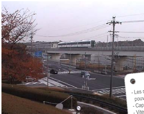
Vue d'une gare, d'une rame, des voies et de leurs supports. L'implantation est ici faite à côté d'une route à deux voies.
